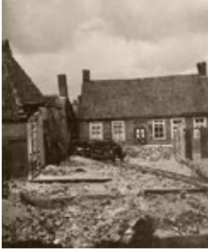
Abriss des Stalls vor dem Haus um 1927
