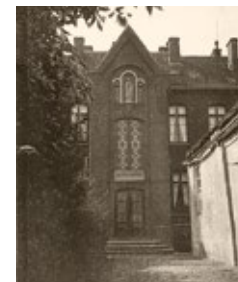
Vorderansicht des Borromäus Hospitals vor 1910
