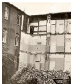
Abriss des Altbaus Anfang der 1950er-Jahre
